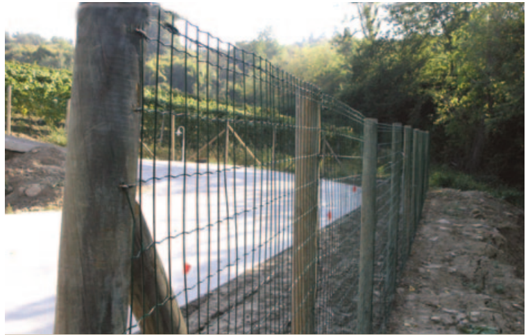
Rete elettrosaldata maglia mm 50x100 e pali di pino tornito
