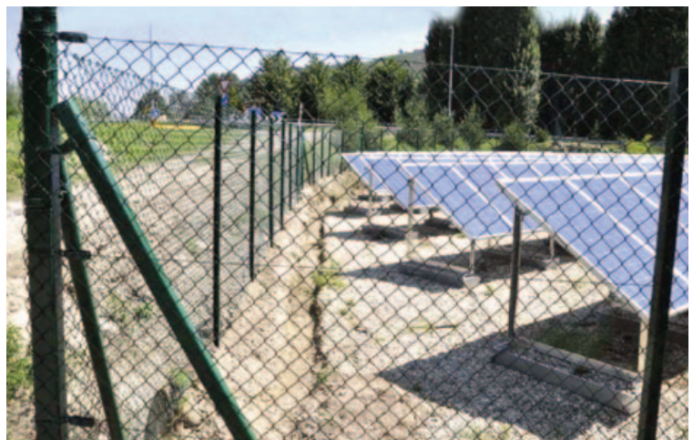
Rete Freeplast e pali in ferro zincati verdi
