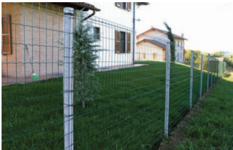
Rete elettrosaldata maglia mm 50x100 e pali di cemento
