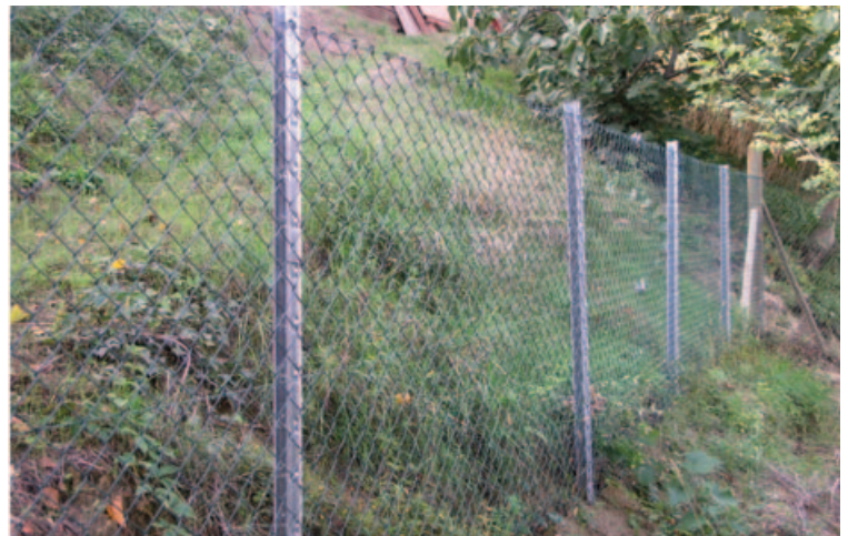
Rete Freeplast e pali in ferro zincati a caldo
