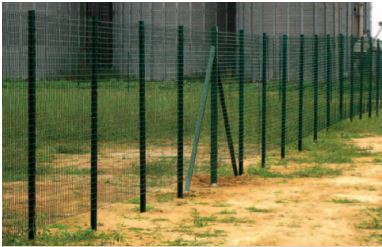
Rete elettrosaldata maglia mm 50x50 e pali metallo zincati verdi
