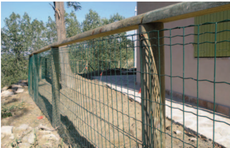
Rete elettrosaldata maglia mm 50x100 e pali di pino
