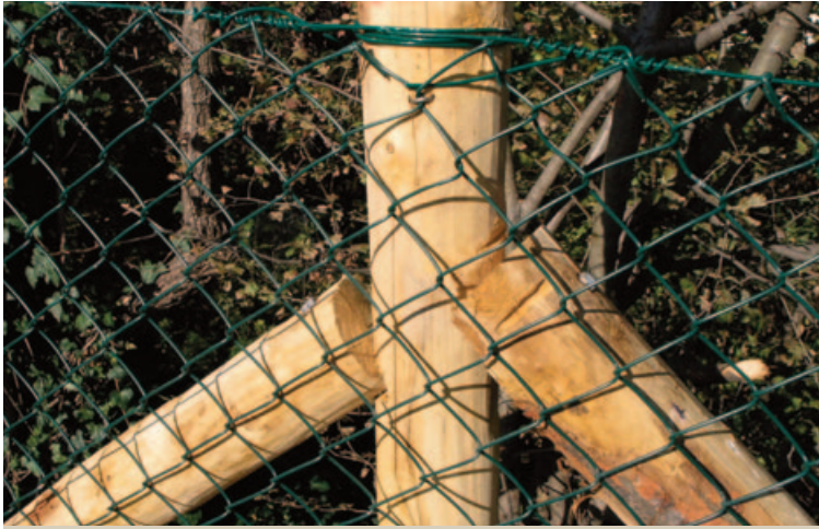
Rete Freeplast e pali di castagno
