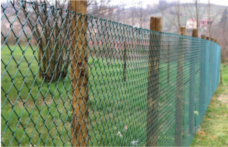
Rete Freeplast e pali di castagno
