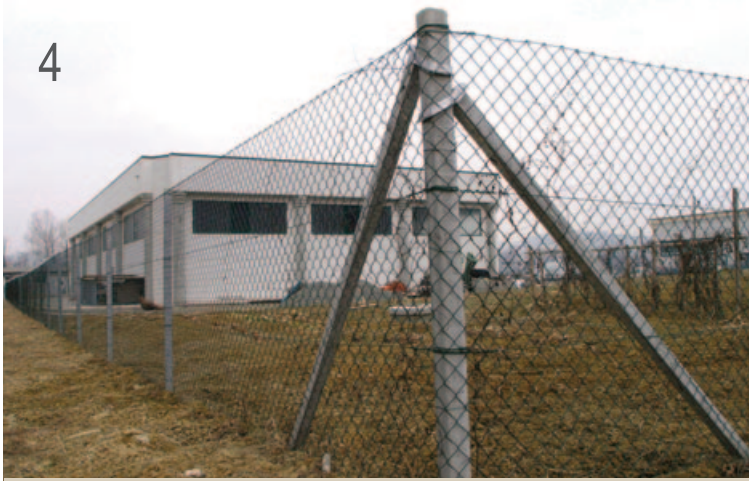
Rete Freeplast e pali di cemento
