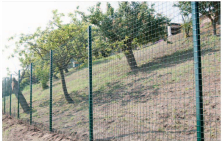
Rete elettrosaldata maglia mm 50x50 e pali in ferro zincati verdi
