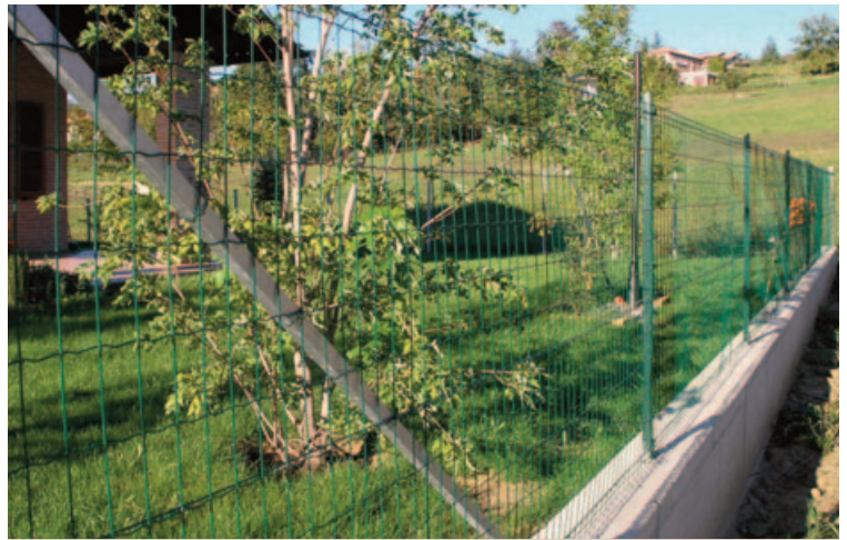
Rete elettrosaldata maglia mm 50x100 e paletti a T
