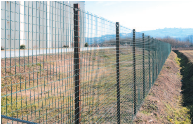
Rete elettrosaldata maglia mm 50x50 e pali in ferro lamiera cor-ten
